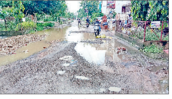
नारनौल। हुडा में भाई रामसिंह की कोटी के पास टूटी सड़क एवं भरा पानी व एडवोकेट राव पृथ्वीसिंह के आवास के समीप खोदा गया सीवर का गड्ढा।
